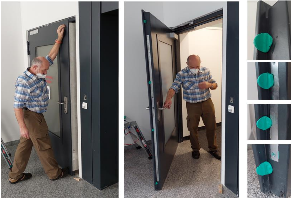
Abbildung 10: Einfache Methode zur Feststellung verdeckter Maße (z.B. Kollisionsfreiräume)
