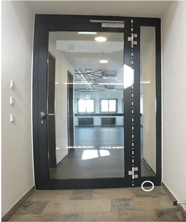
Abbildung 5: Fixierung des Seitenteils, dauerhaft robuste Vertikalität der Achslage
